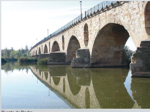
Puente de Piedra
